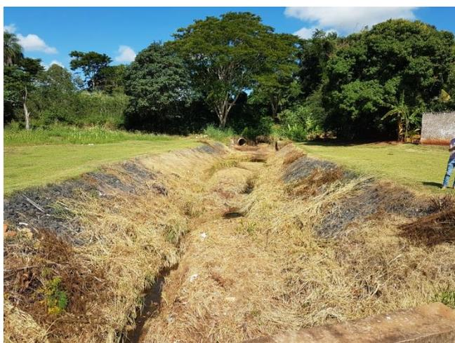
Foto 3.20 – Canal a céu aberto com necessidade de limpeza
