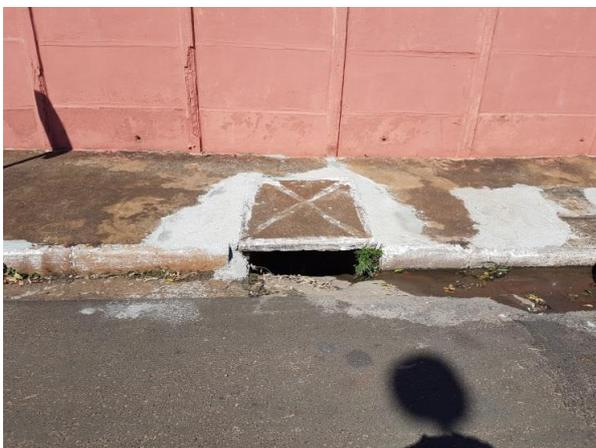
Foto 3.12 – Estrutura de microdrenagem insuficiente
