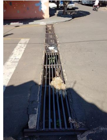
Foto 3.15 – Grelha com necessidade de limpeza
