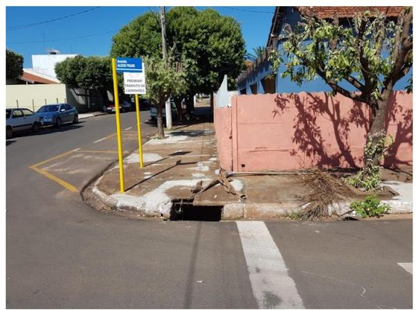
Foto 3.13 – Estrutura de microdrenagem insuficiente
