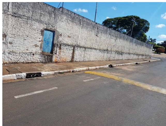
Foto 6.19 – Estrutura de microdrenagem
