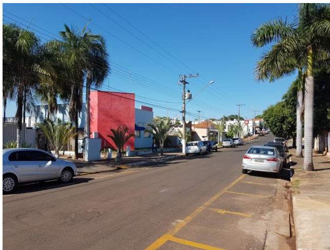
Foto 6.10 – Vista geral da área de alagamento
