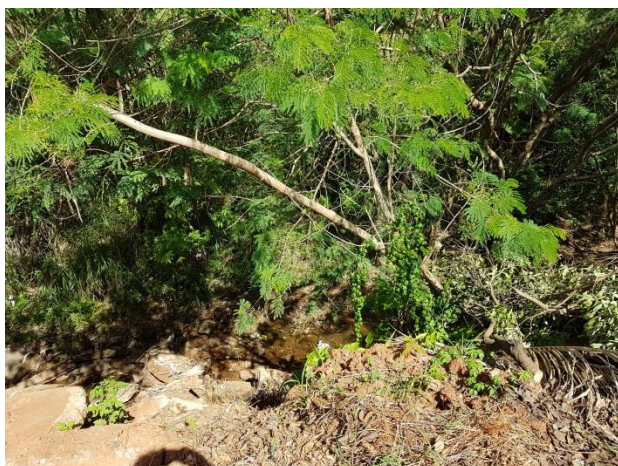
Foto 6.26 – Erosão causada pelo escoamento superficial
