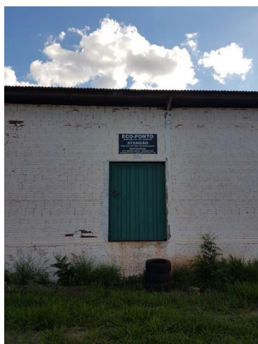
Foto 6.6 – Vista da área de armazenamento de pneus
