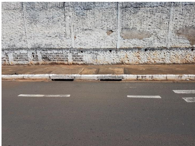
Foto 6.18 – Vista geral da área de alagamento
