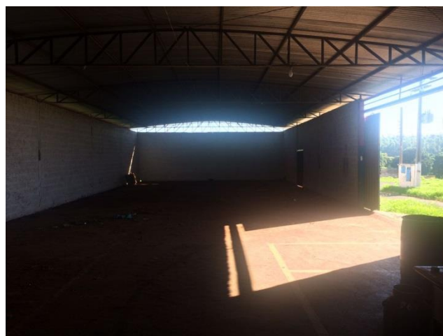
Foto 6.7 - Vista da área de armazenamento de pneus
