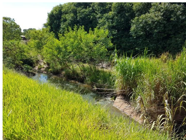
Foto 6.23 – Canal a céu aberto com necessidade de manutenção da estrutura
